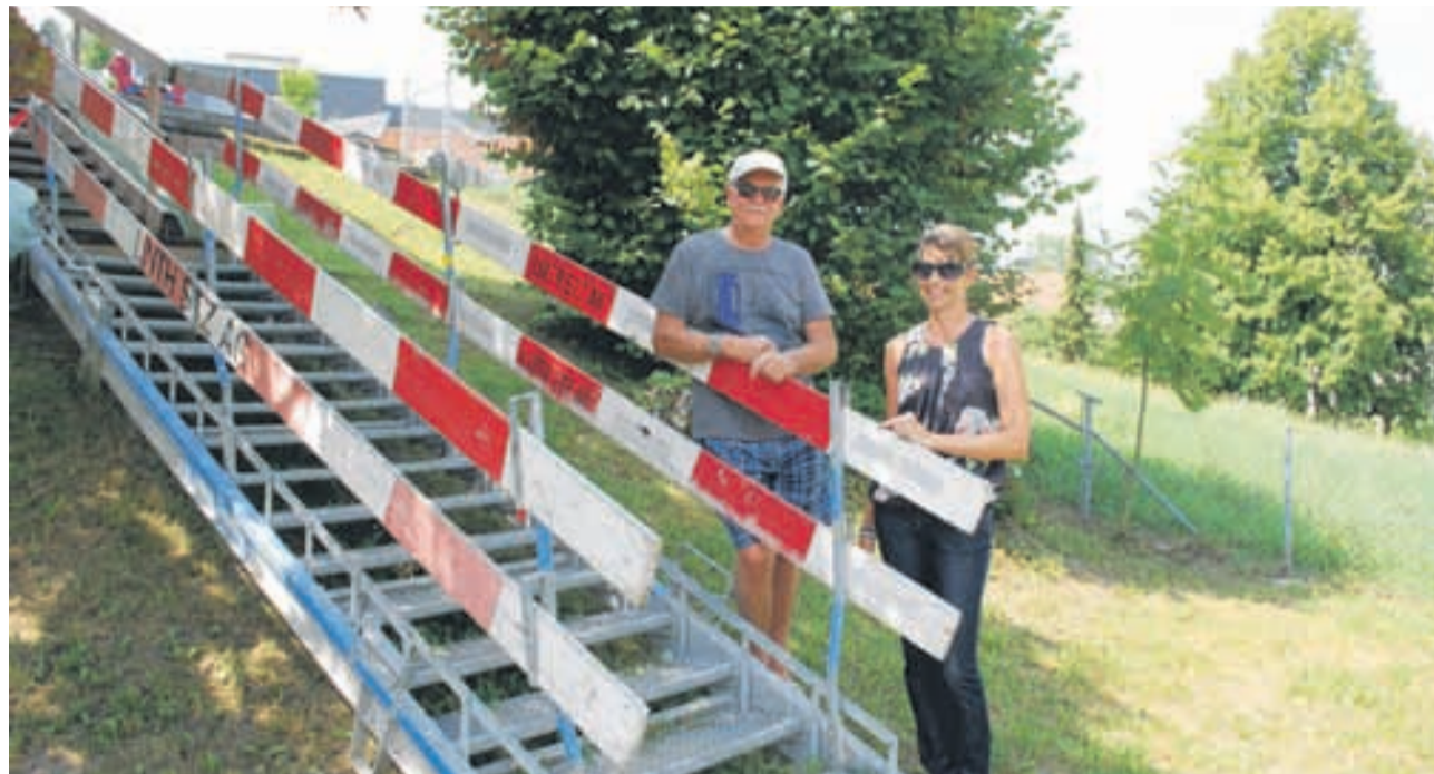
Walter Fügli und Karin Kraus haben Zweifel, ob die Baustellentreppe zum Kindergarteneingang in der Roos tatsächlich für kleine Kinder geeignet ist. Architekt Willi Gärni hingegen betont: «Die Treppe ist sicher und entspricht den Vorschriften.» Bild Bianca Anderegg
